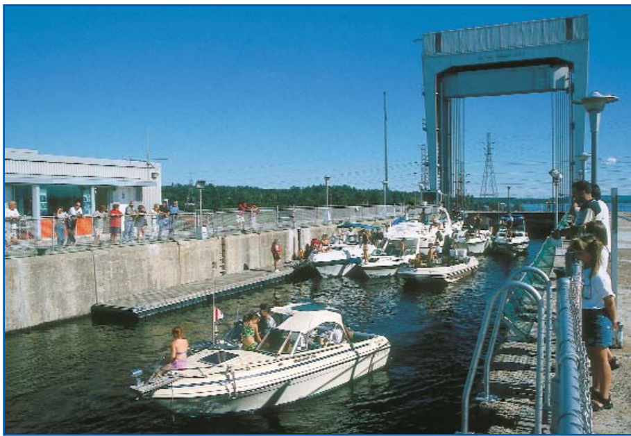
L'écluse de Carillon permet de franchir une dénivellation de 20 mètres.
