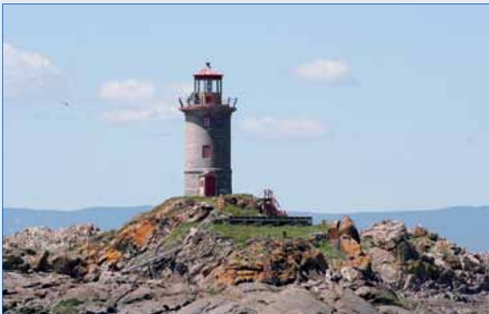
Les Amis du Port-Joli ont réussi à sauver de la ruine le phare du Pilier de Pierre. La maison du gardien et les petits bâtiments de servitude ont malheureusement disparu.
