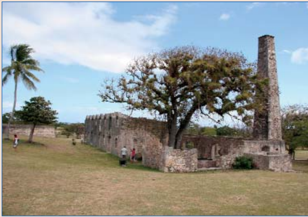
Les ruines de la chaufferie de L'Habitation Murat, une ferme sucrière du XVIII e siècle.
