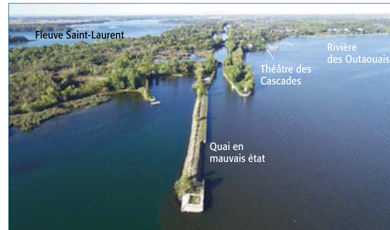
La pointe des Cascades et l'entrée aval du canal de Soulanges.
